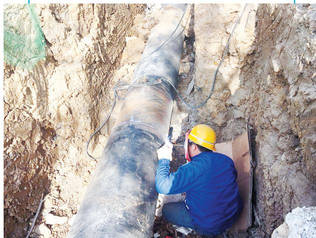
11月22日,热力工人正在郾城区井冈山路安装热力管网。井冈山路、文明路热力管网工程项目从井冈山路与纬八路交叉口起,沿井冈山路向北至文明路,然后沿文明路向西至107国道,全长约1400米,目前已经完成1000米。管网建成后可以满足井冈山路沿线各个企业的用热需求。
