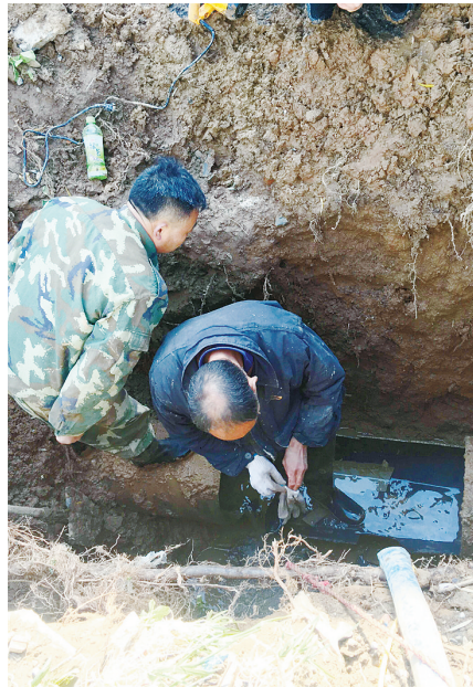
抢修人员正在维修自来水管。 本报记者 王麓棣 摄
