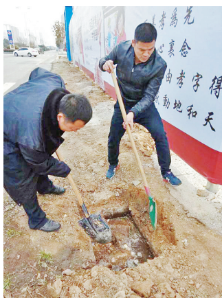
张凯（右一）正在对破损的污水井盖进行维修。
