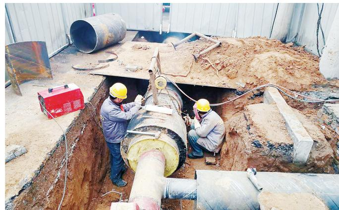
1月17日,在市区黄山路,工人正在焊接热力管道。黄山路集中供热管网项目管网全长2700米,现已完成管网敷设约2200米,这是沙北第一条热力主管网,对推动集中供暖进入千家万户具有重要意义。 本报记者 王艳彬 摄
