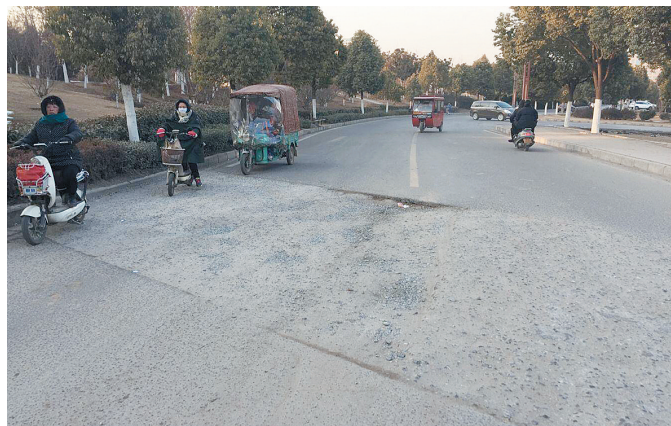
破损的路面。
