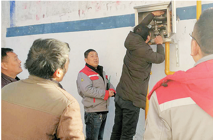
工作人员在对燃气管道进行检修。
