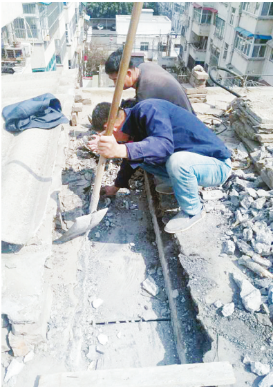
图为工人正在修复厨房屋顶。
