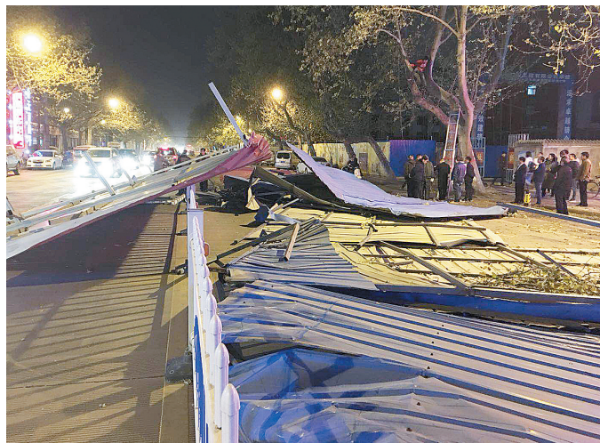
大风刮落的隔热层铁皮。
