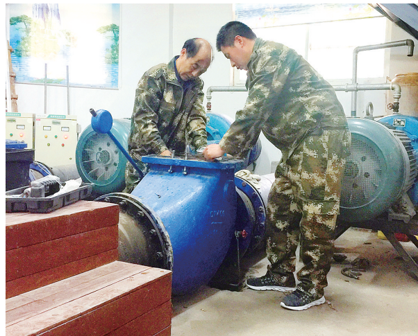
汛期即将到来，我市抽排泵站正在对设备进行全面检修调试，做好抽排准备。图为工作人员正在检修设备。 本报记者 张晓楠 摄
