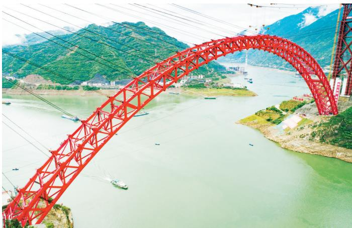
5月22日,世界最大跨度钢箱桁架推力式拱桥——香溪长江大桥主拱成功合龙,这座位于三峡库区的长江大桥顺利迈过施工风险最高、难度最大阶段,离全线贯通更近一步。
