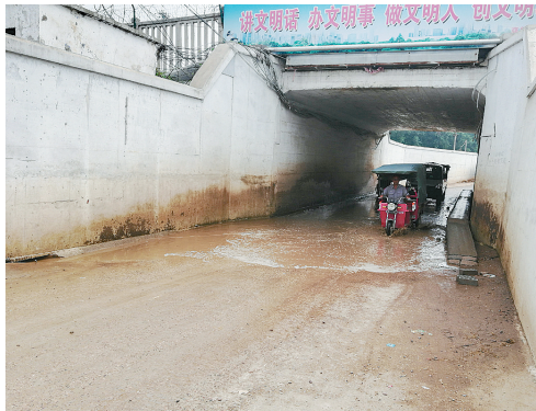
商桥镇附近的铁路涵洞雨后积水难行。
