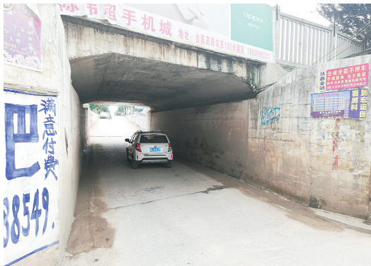
台陈镇小湛庄附近的铁路涵洞通行顺畅。
