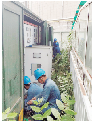
供电公司工作人员正在紧张施工。本报记者齐放摄
