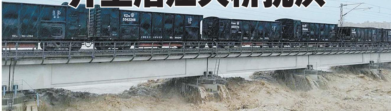
四川连日来遭遇持续暴雨袭击。7月11日10时起，四川启动全省II级防汛应急响应，这是多年来四川首次启动此级别应急响应。11日上午，由于涪江绵阳段的水位迅速上涨，对宝成铁路涪江大桥造成影响，中国铁路成都局集团有限公司调集两列每节70吨左右的重载货物列车上桥，通过“重车压梁”的方式，抵抗洪峰。
