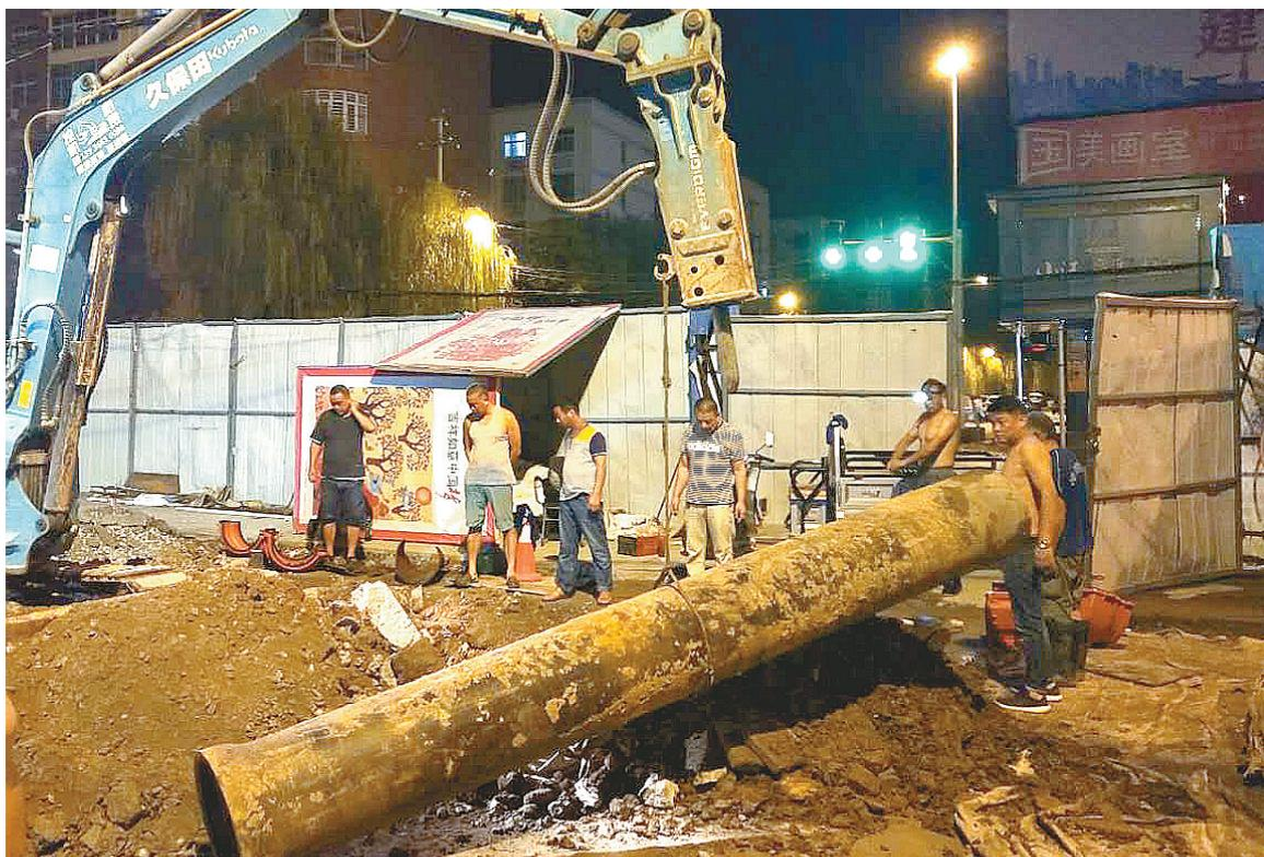
7月31日下午,市区供水管网水压突然下降,市民用水受到影响。找到主供水管网爆裂点后,供水公司抢修人员连夜抢修7个多小时,使供水恢复正常。图为抢修现场。
