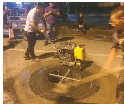
工人们在建设路安装新型窨井盖。
