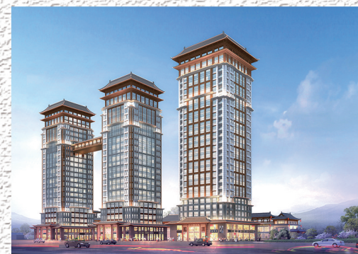
河上街广场 (建设中)
