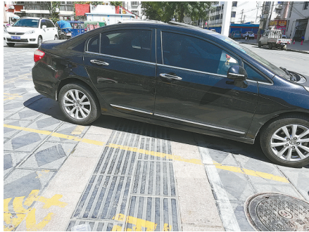
一家购物广场的盲道上写着“商场车位”,盲道被车辆占据。
