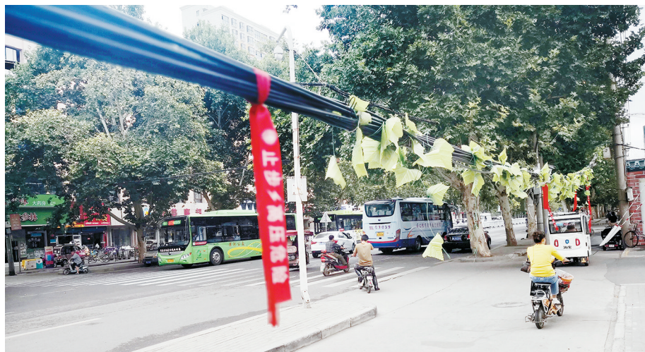
线缆垂落,距离地面仅有一两米。
