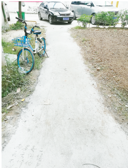
刚修好的水泥小路。
