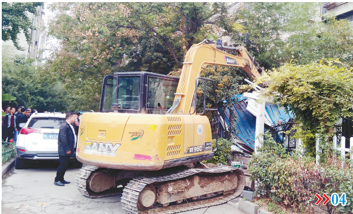
10月20日上午,市城管局、郾城区联合行动,对黄山小区临时构筑物、毁绿占绿设置的围墙栅栏等30多处违法建筑设施进行拆除。 本报记者 于文博 摄
