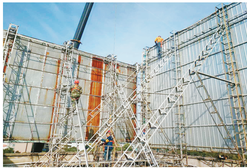
户外广告拆除现场。
