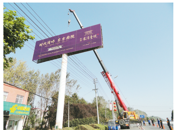
市城乡一体化示范区组织人员对辖区内排查出的违法户外广告牌进行拆除,截至目前,已拆除33处违法户外广告牌。图为10月23日,工作人员在市区金山路拆除违法户外广告牌。
