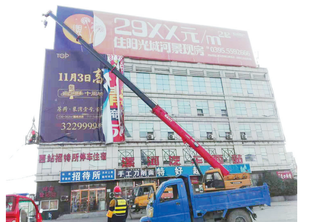
10月24日,源汇区干河陈乡联合市城市管理综合执法支队源汇大队,对市汽车西站楼顶大型户外广告牌进行依法拆除,共拆除大型户外广告牌7处,拆除面积近800平方米。
