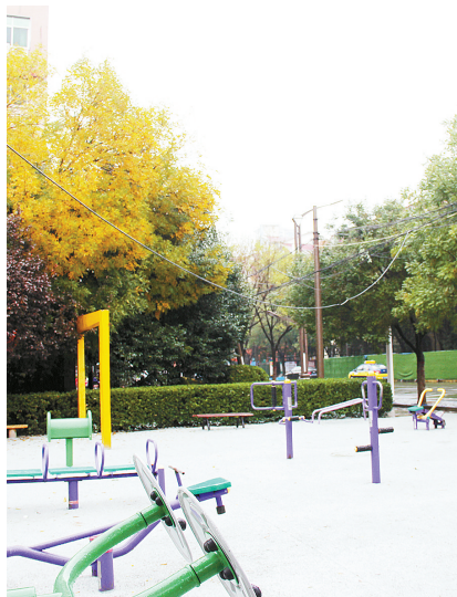
市区辽河路与泰山路交叉口街头游园，健身器材上空一根线缆低垂下来。
