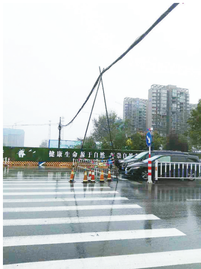
市区淞江路与泰山路交叉口，马路中间两根木棍撑着线缆。
