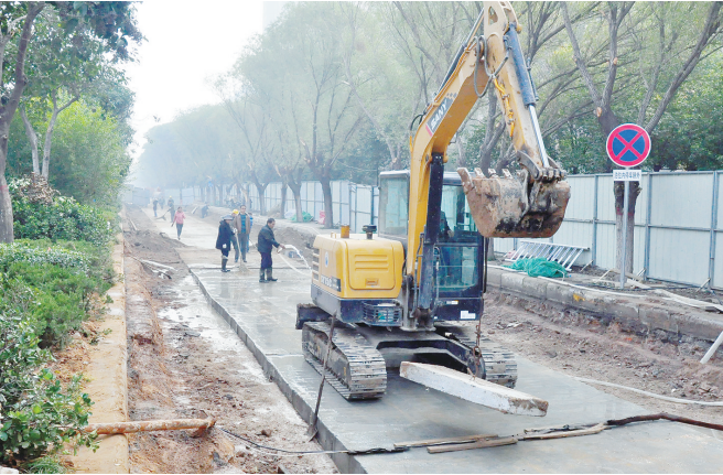
淞江路上正在施工的雨污分流工程项目。
