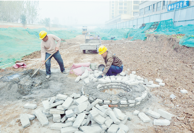
泰山路北段打通工程正在施工。
