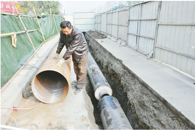
祁山路北段正在施工的供热管道。
