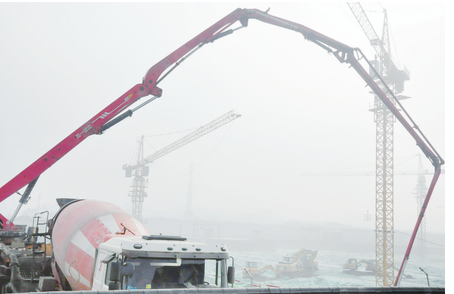
正在施工的郾城区第五实验小学。
