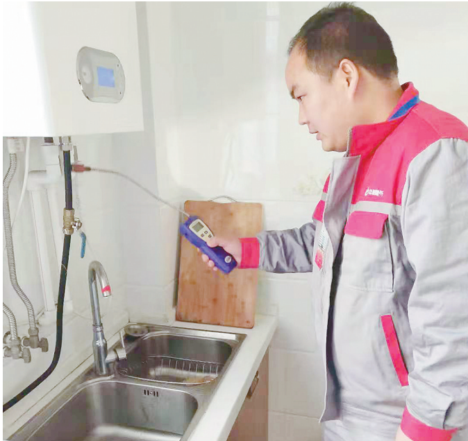
安检人员正在对居民家中的燃气设备进行安检。
