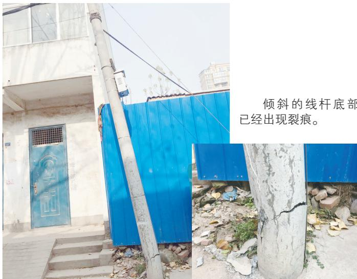
倾斜的线杆底部已经出现裂痕。
