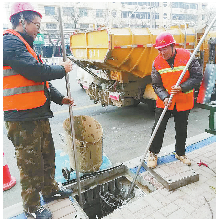
蒋遂坡（右）和同事疏通排水管网。
