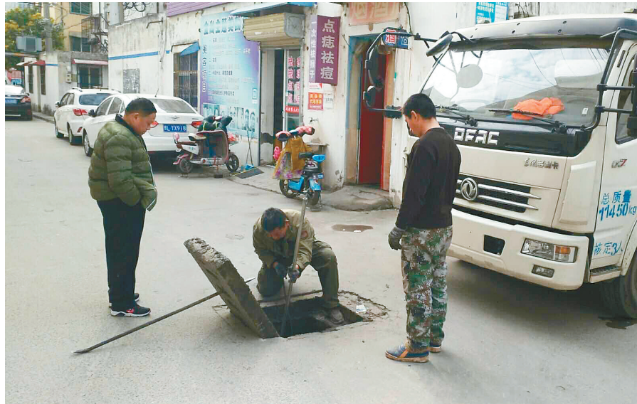
施工人员正在疏通下水道。
