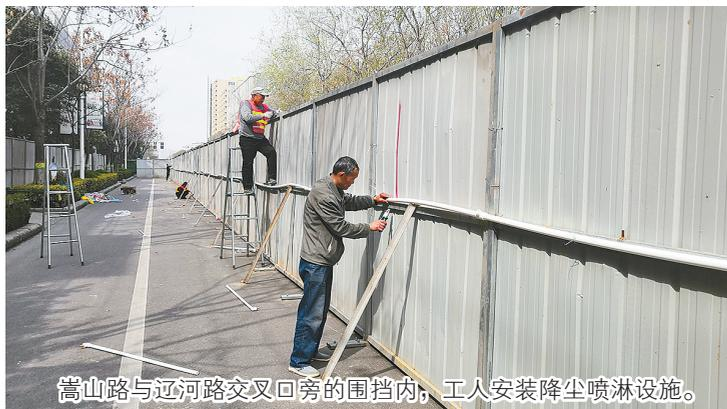
嵩山路与辽河路交叉回路的围挡内,工人安装降尘喷淋设施。
