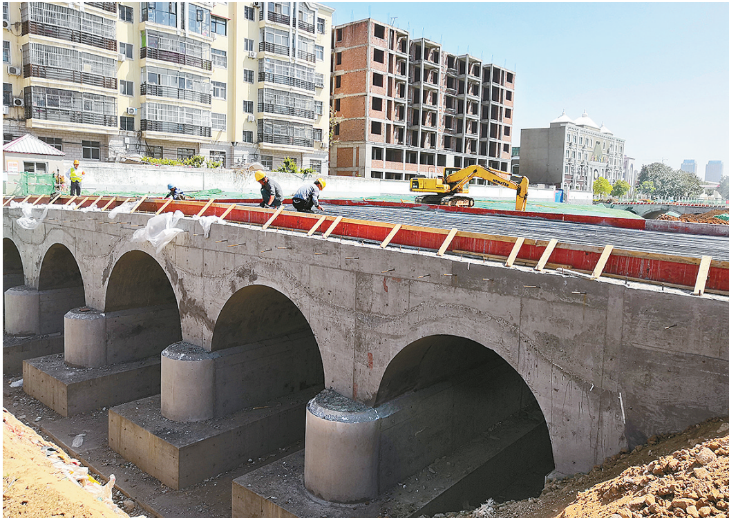
淞江路与井冈山路交叉口附近的景观桥即将完工。
