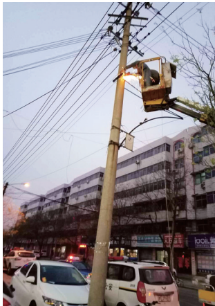
市路灯维护中心对路灯进行全面排查和维修。
