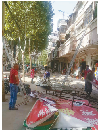
纺织路上一些商铺的门头招牌已被拆除，接下来将安装新的门头招牌。 本报记者 张晓甫 摄
