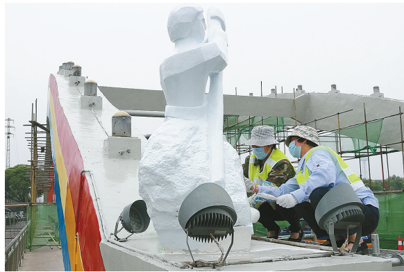
5月5日，工人在市区泰山路彩虹桥喷涂新涂料，清洗大桥主体和路灯、亮化设施，让彩虹桥以靓丽风采迎接食博会。 本报记者 范子恒 摄
