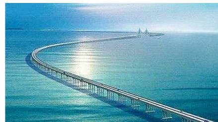
港珠澳大桥全长55公里，是世界上最长的跨海大桥。它包括22.9公里的钢结构主体桥梁，4个人工岛和一段6.7公里的世界最长海底沉管隧道。港珠澳大桥项目所体现的不仅仅是中国过去几十年建桥技术的积累，它同时也在重新定义中国制造未来的方向。
