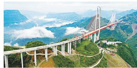
贵州北盘江大桥是世界上第一座上承式推力转体式铁路钢管混凝土拱桥，桥面距江面高差达280米，桥长468.2米，主跨为236米上承式钢管混凝土推力结构，其跨度、高度、转体重量和转盘大小居世界同类型桥梁之首。2016年12月29日竣工通车。2003年荣获鲁班奖，2004年荣获天佑土木工程大奖。
