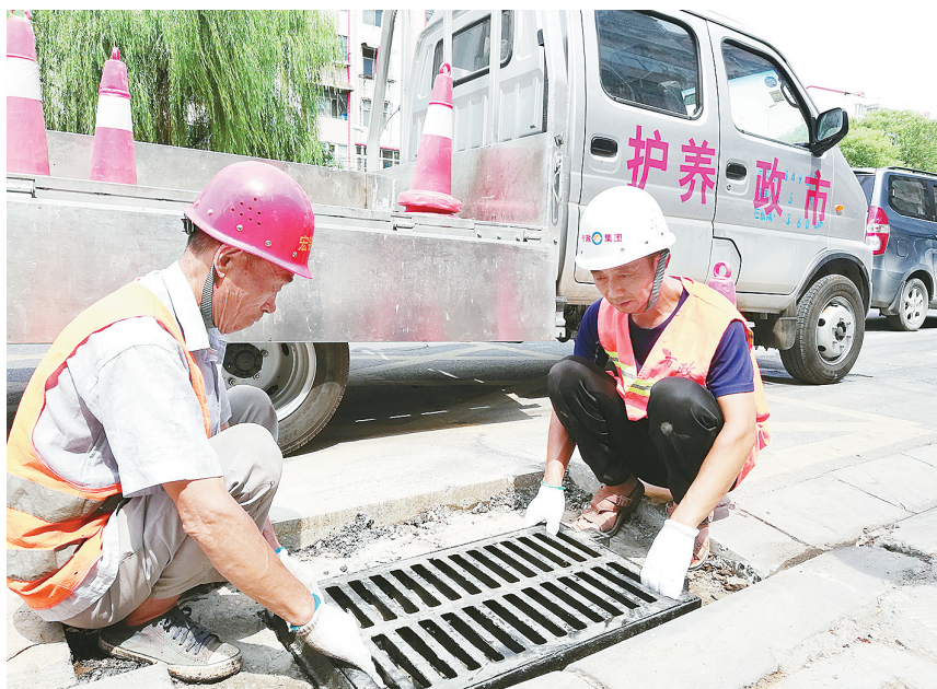
工人们正在铺设窨井盖。
