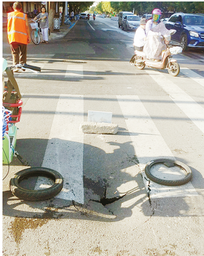
路面出现小洞、裂缝，发生凹陷。
