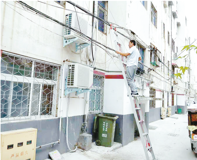
工作人员在金牛社区捆扎空中管线。
