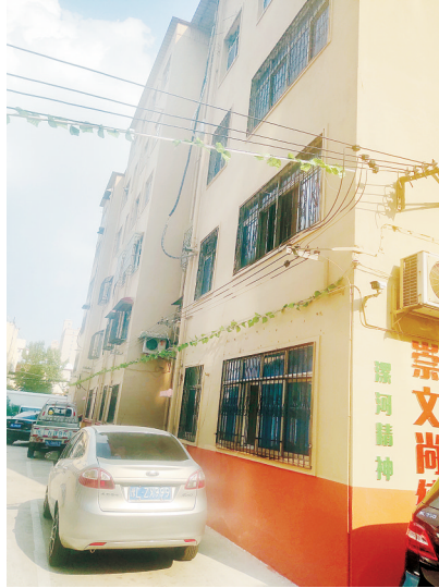
海河路时代公馆整改后的空中线缆。
