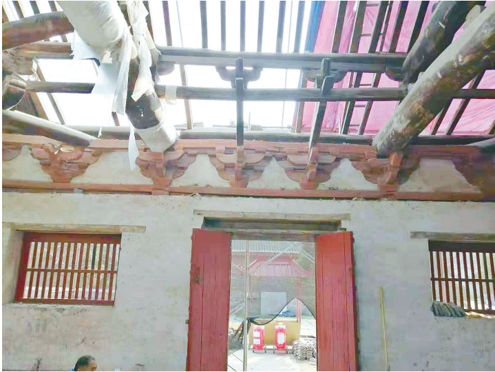
图为正在进行修缮的中佛殿屋顶，一砖一瓦仍透着久远的气息。
