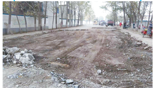
11月22日,记者在郾城区中原路南段看到,破损路面被挖开,混凝土块被运走。中原路南段开始整修。 本报记者 张新锐 摄
