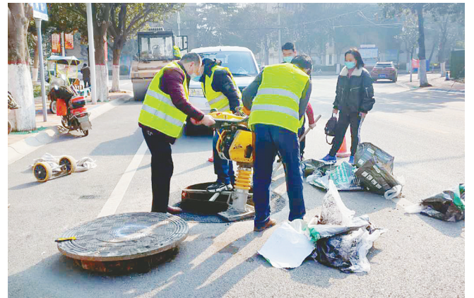
3月3日，市市政建设和公用服务中心工作人员在市区淮南路安装新型窨井盖。据了解，此次窨井盖集中更换涉及道路十余条、窨井46个，预计3月10日全部完工。 本报记者 朱红 摄
