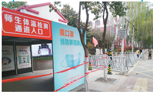
3月16日,记者在市区黄山路漯河小学门口看到,工人正在安装隔离栏,校门口南边已建成师生体温检测通道,积极为开学做准备。 本报记者 齐放 摄
