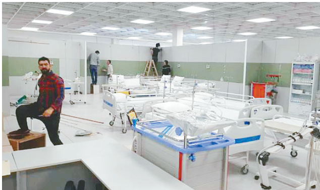
正在改造中的方舱医院。
