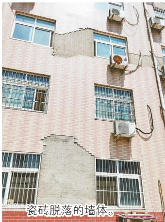
瓷砖脱落的墙体。
