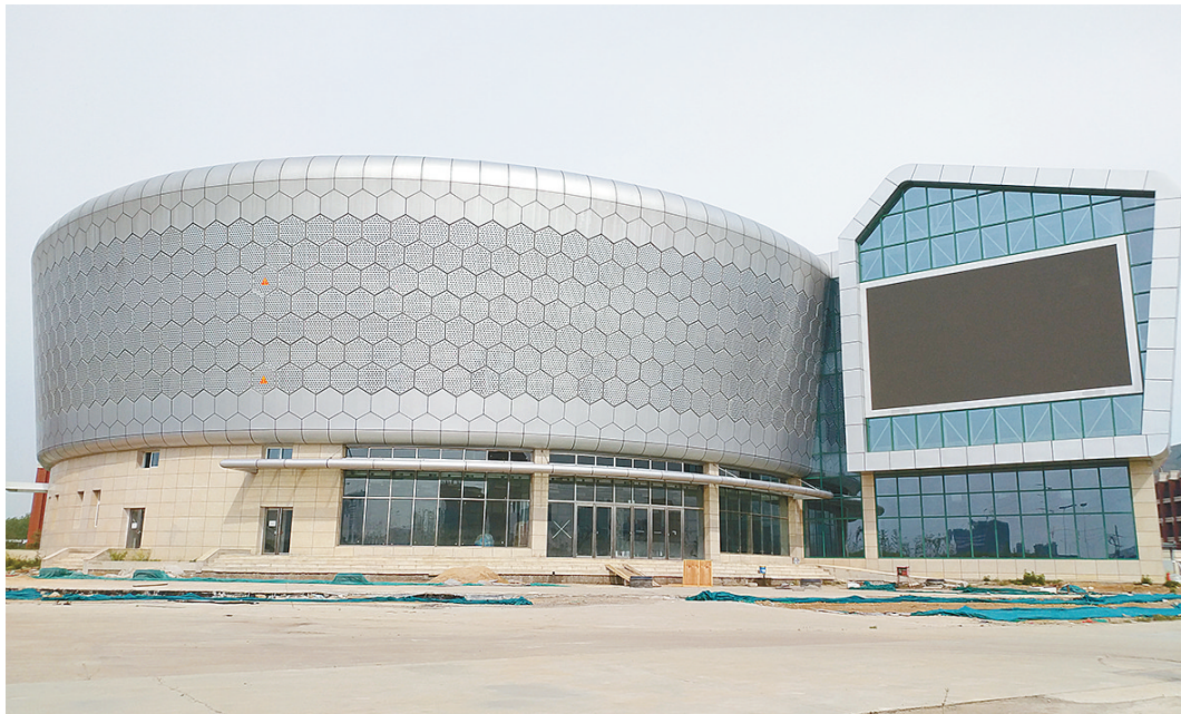
市科技馆地上地下主体工程已经完工。
