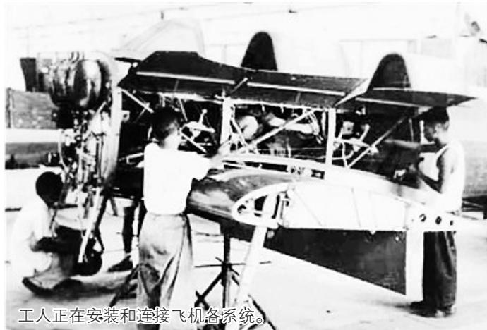
工人正在安装和连接飞机各系统。
