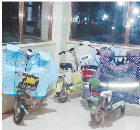
金色龙湾小区,多量电动自行车占用消防通道,在楼梯间充电。
