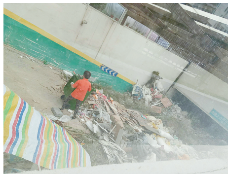
市区金山路御园小区9号楼南车库入口变成了垃圾场。天气炎热,蚊虫滋生,影响居民生活。
