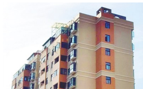
碧湖御苑小区39号楼1单元1101室居民在天台违规建房。
