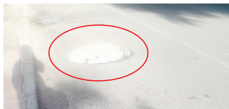
五一路与马路街交叉口东50米，有个直径1米、深20厘米的坑。
