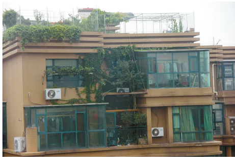
黄河路金地兰乔圣菲小区，7号楼18楼南户在楼顶私搭乱建。
