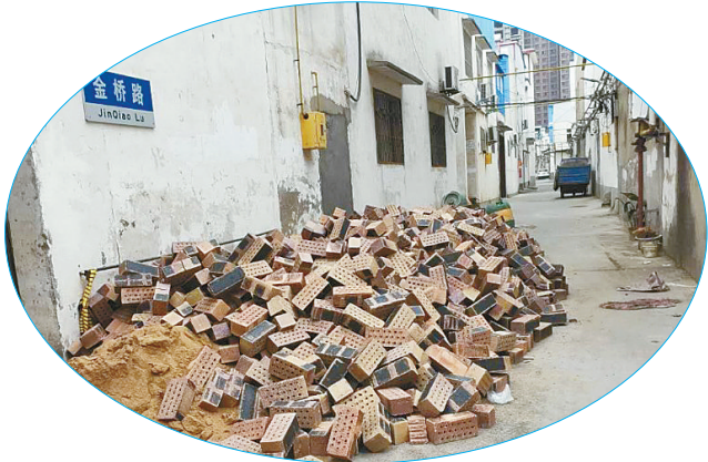
6月10日，郾城区解放北路与金桥路附近一居民装修房屋，墙砖散落在路面，影响附近居民通行。 见习记者 刘净旖 摄
